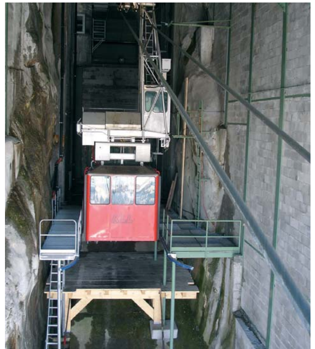
Die 5-to-Windenbahn in der Bergstation (Habegger 1958)
