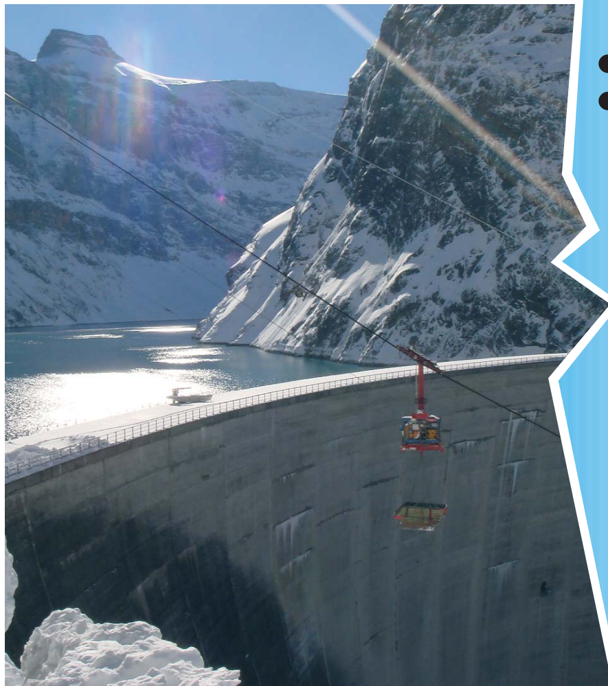
10-to-Materialseilbahn zur Erschliessung des Sondierstollens
