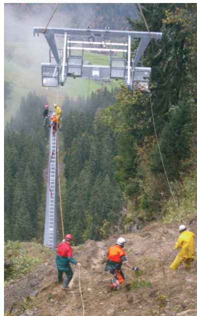
Montage der Stützen
